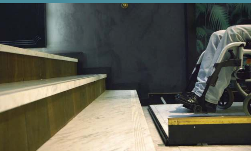
Hochfahren der Fallschutzbleche
